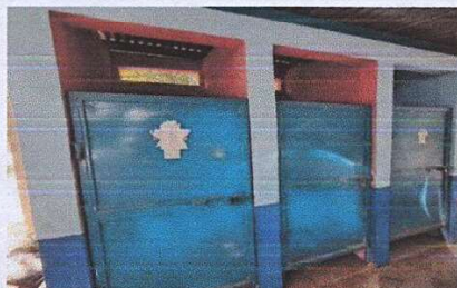
Foto 1: Reparación de baños, con estructura metálica y lamina troquelada calibre 26.
