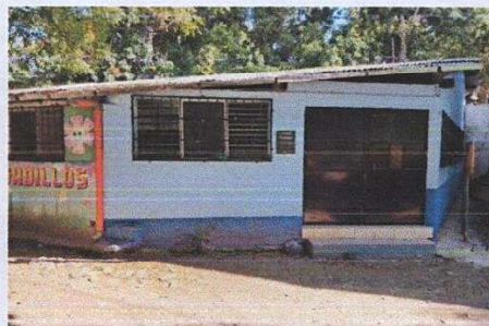
Foto 4: instalación de ventanas tipo pvc
