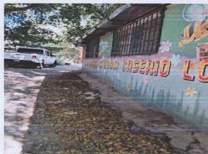
Foto 2: Reparación de banqueta con su respectivo diente para protección de la escuela.
